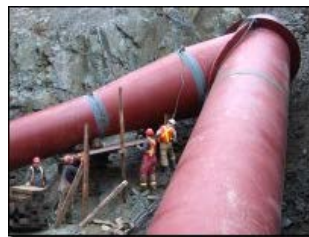
Mamquam Hydro Project
